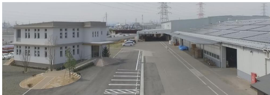
完成した事務所 (右はナイス仙台物流センター)
