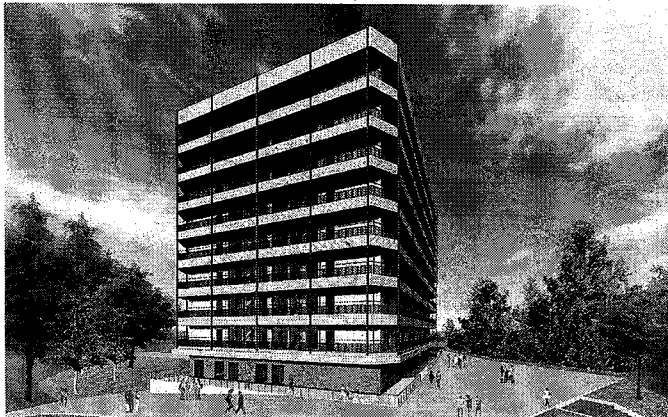
純木造9階建て学生寮の建設を計画
