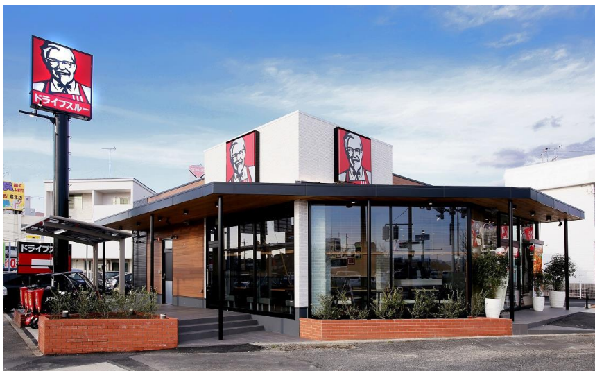
【店舗】床・内装材をCLTユニット化
