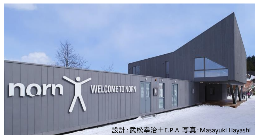
【スキー場の事務所（倉庫等）】をユニット化
