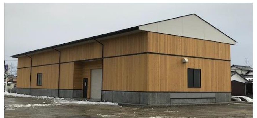
CLTのユニット化【倉庫】
