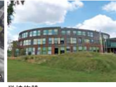
学校施設(イギリス・ノーリッチ)
