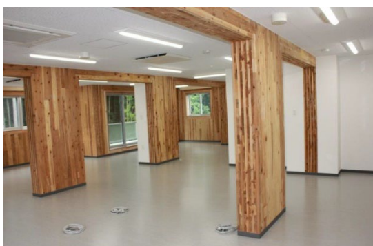
【事例1】株式会社コスモスウェブ（社屋） 県内初の3階建CLT建築 CLTパネル工法（ルート2）
