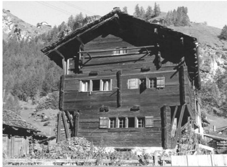
16 世紀の山間部の住宅 (Evolène, スイス) 中層階が18世紀に追加された
