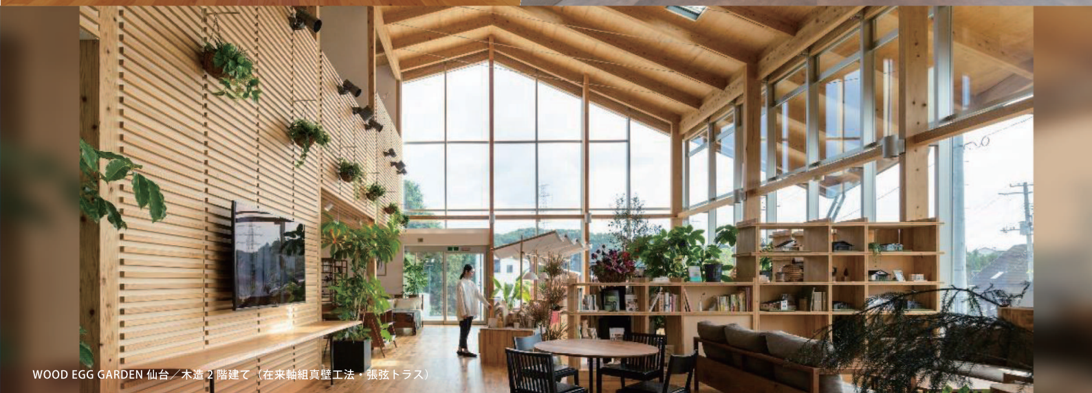
蔵王パティオ / 木造2階建て (在来軸組工法+CLTカルバートラス)
