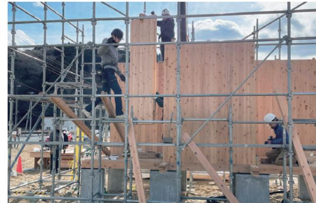
製造した壁用DLT(施工の様子)
